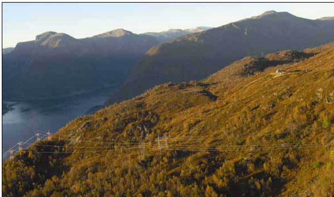
Figur 63: Rudsstølen i Leikanger. Nærmeste ledning er 132(300) kV Fardal – Stølsdalen med fjordspenn over Fjærlandsfjorden. Dagens ledning vil bli revet og ny ledning bygget i samme trasé. Den andre ledningen er 132 kV-ledningen Fardal – Mel som her vinkler nordover.
