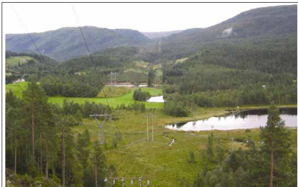
Figur 42: Storebru/Sørdalen i Flora mot sørøst. Fotomontasjen viser nye 420 kV-ledning der den er planlagt parallelt med dagens 132 kV og 66 kV-ledninger gjennom Storebruområdet. Deler av området (myra) er vernet som naturreservat. Det er fugletrekk ut langs elva på tvers av ledningene. På andre siden av elva (øst for elva) ligger det en driftsbygning på venstre hånd som kommer tett inn på ledningen dersom denne traséløsningen velges. Illustrasjon: Agraff AS. Se også detaljert kart i Figur 88.
