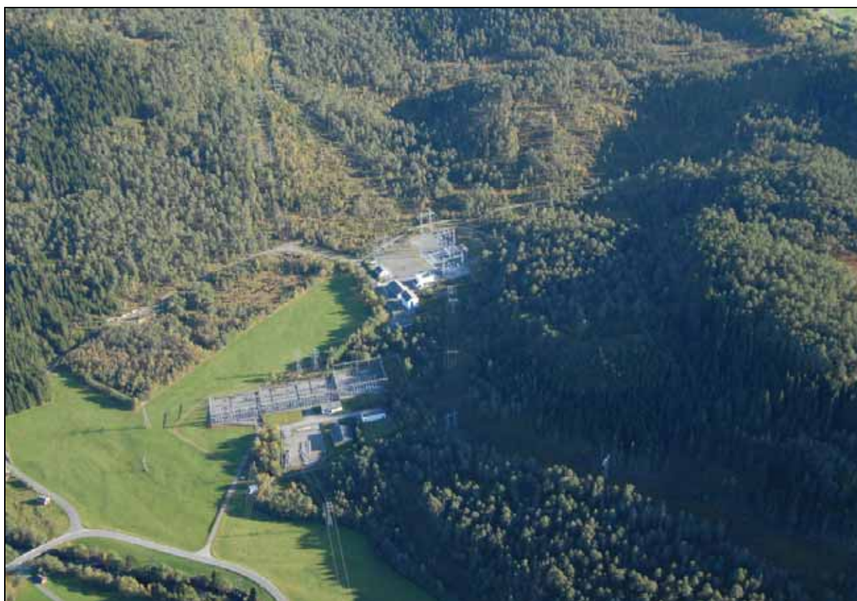
Figur 71: Ørskog transformatorstasjon. Bildet viser dagens stasjonsanlegg. Til venstre sees dagens 132 kV stasjon (Giskemo) og lengre bort til høyre dagens 420 kV-anlegg. Det søkes nå om utvidelse av 420 kV-anlegget mot sør (til høyre). Plantegning, bilde og snitt for stasjonen er vis i vedlegg 4.
