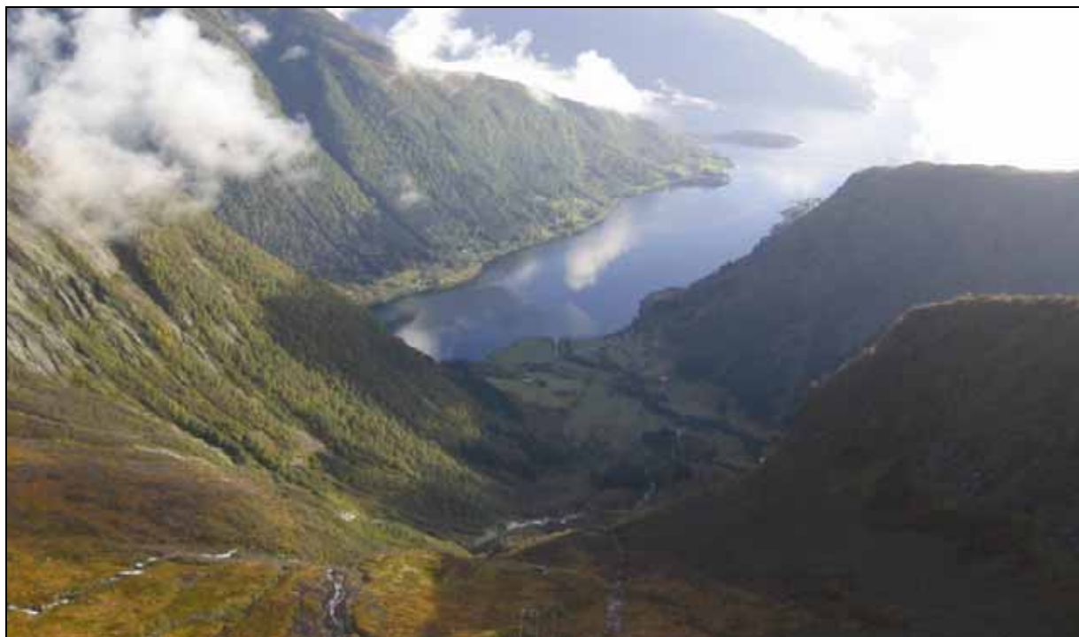
Figur 61: Esebotn mot Balestrand. Bildet viser dagens 132(300) kV-ledning i dette området. Denne vil bli revet og ny ledning bygget i hovedsak i samme trasé. Mastehøyder, trasébredde og spennlengder for ny ledning blir omtrent som for dagens ledning. I bakgrunnen sees kryssingen av Esefjorden.
