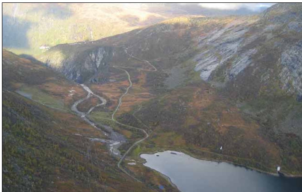
Figur 60: Eiriksdalen i Høyanger. Bildet er tatt mot nordvest og viser dagens 132(300) kV-ledning som passerer Roesvatnet, før den krysser Gautingsdalen og går inn til Stølsdalen til høyre i bakkant av bildet.
