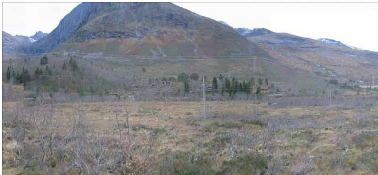
Figur 13: Standaleidet/Myklebustsætra i Ørsta. Bildet er tatt mot sørøst fra veien mot Heimste Kopphornet. Fotomontasjen viser planlagt 420 kV-ledning etter traséalternativ 1.2. I forgrunnen sees dagens 132 kV-ledning. Illustrasjon: Agraff AS.
