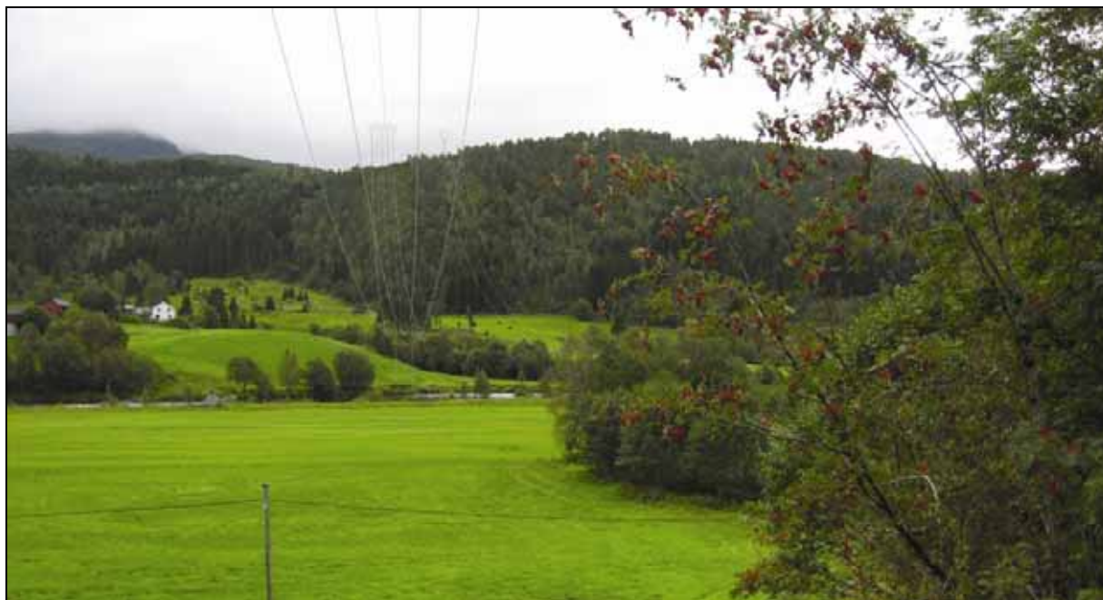
Figur 43: Kryssingen av Naustdal sørøstover mot Grimset for trasealternativ 1.0. Ny 420 kV-ledning er her lagt parallelt med dagens 132 kV-ledning. Illustrasjon: Agraff AS. Se også detaljert kart i Figur 90.
