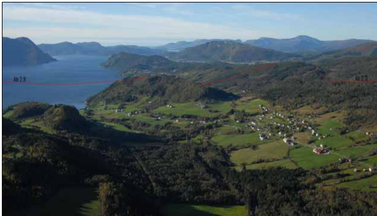
Figur 20: Vagsvika i Ørskog. Med rød strek er vist trasé for alternativ 2.8 som krysser Storfjorden fra Solliåsen midt i bildet. Til høyre sees traséalternativ 2.0 som går parallelt med dagens ledning sørover fra Ørskog transformatorstasjon.
