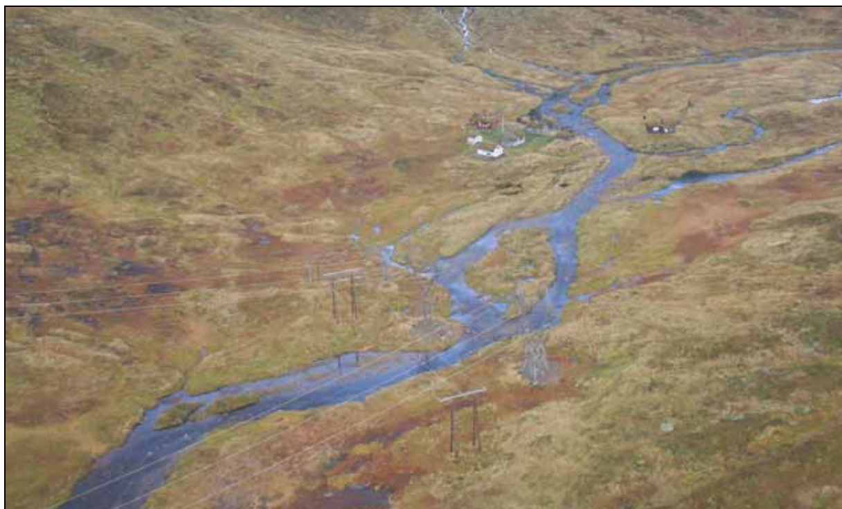
Figur 55: Stølsdalen i Gaular på grensen til Høyanger. Bildet viser dagens anlegg i Stølsdalen. Her møter 132 kV kraftledninger fra Høyanger, fra Fardal og fra Moskog. Den nærmeste stålmasterledningen er 123(300) kV-ledning Fardal – Stølsdalen. Den neste er viderføringen til Høyanger mot venstre. Lengst borte ligger 132 kV stålmasterledning Høyanger – Moskog.
