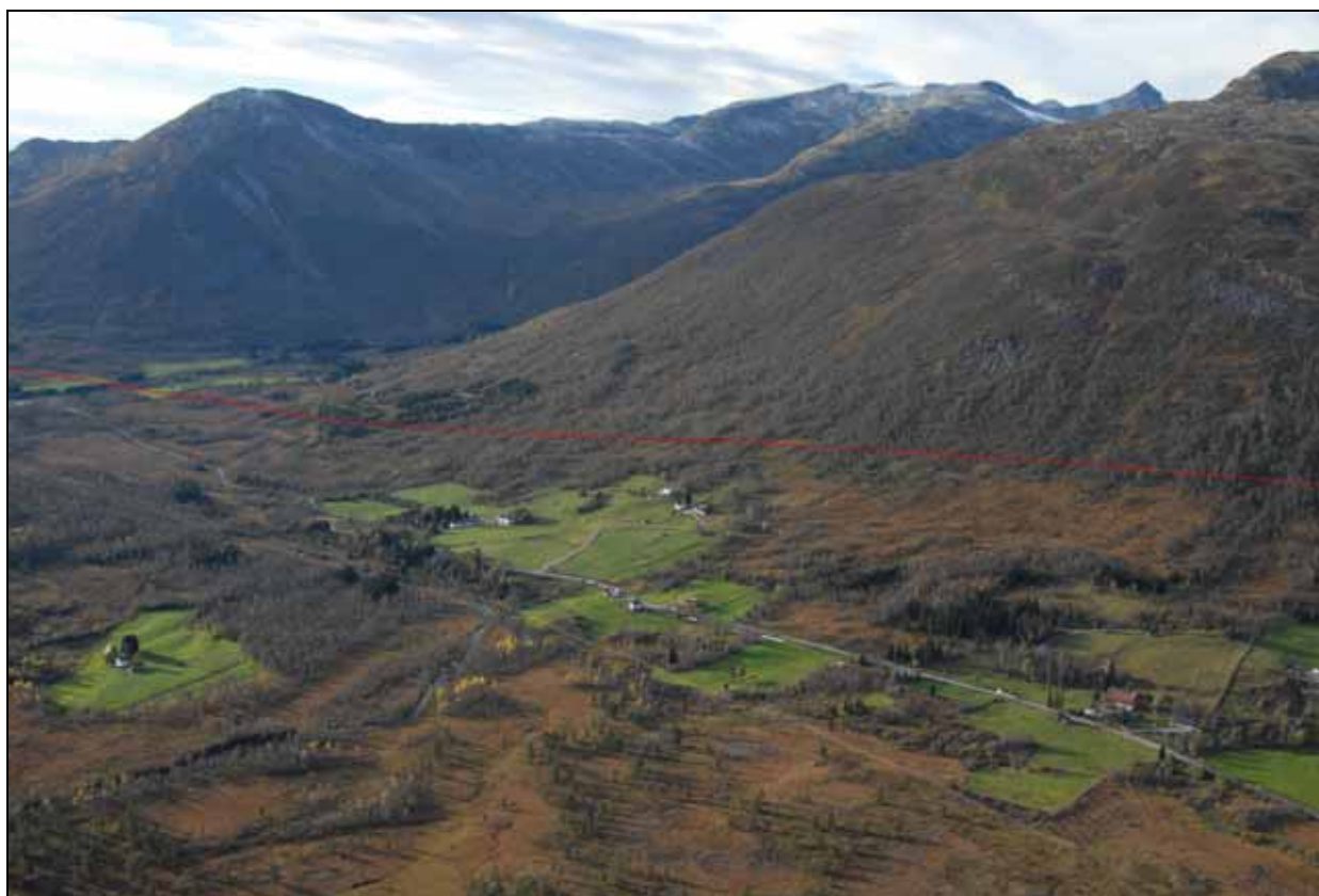
Figur 29: Hornindal. Med rød strek er vist traséalternativ 2.4 som går i bakkant av Kjelstadli (Stranda) til høyre og vestover i fremkant av Sætedalen.
