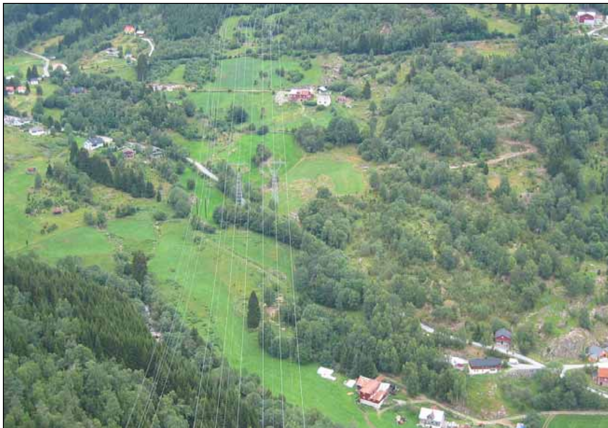
Figur 67: Øvstedalen i Sogndal. Bildet viser dagens ledningsnett ut fra Fardal ved kryssing av nedre deler av Øvstedalen ved Uppheim. Til venstre sees 132 kV trestolpeledning Fardal – Mel, i midten dagens 132(300) kV-ledning Fardal – Stølsdalen, og til høyre dagens 300 kV-ledning Fardal – Leirdøla. Mastebildet i dette området vil endre seg ved ulike valg av traséalternativer ut fra Fardal. Dette er illustrert i Figur 68. Se også detaljert kart i Figur 92.
