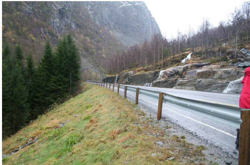
Foto 6-1. E39 i Stigedalen (foto Jøsok).
