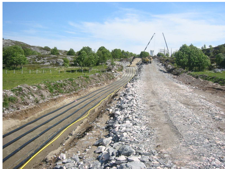
Foto 5 - 1 Kabeltrase Ormen Lange Arealbredde 20 m inklusive vei og massedeponi (Foto Statnett)
