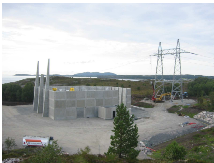
Foto 3 -2 Kabelmuffehus Ormen Lange under bygging (Foto Statnett)
