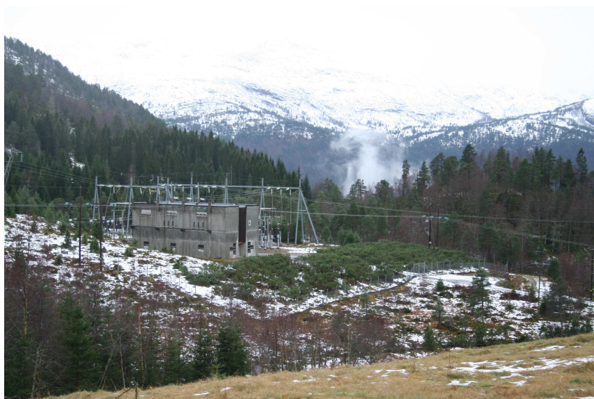
Foto 6 - 6. Leivdal Transformatorstasjon (Foto Jøsok).
