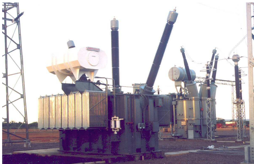
Foto 3 – 5 Typiske trefase reaktorer (størrelse ca 100 MVar)
