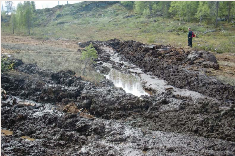
Figur 41 Terrenngskade etter massetransport, Pasvik våren 2010.
