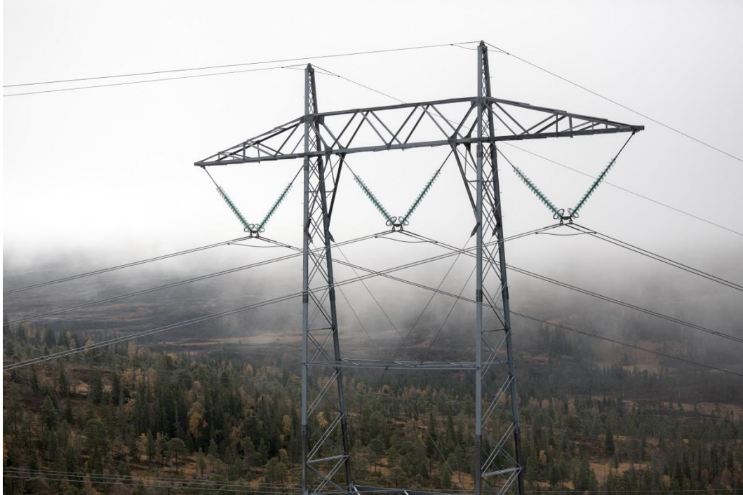
Figur 6: Oppgradert V-kjede bæremast med isolatorskåler i ulik fargenyans (mast nr 159 mellom Tunnsjødal og Namsskogan, 2013).
