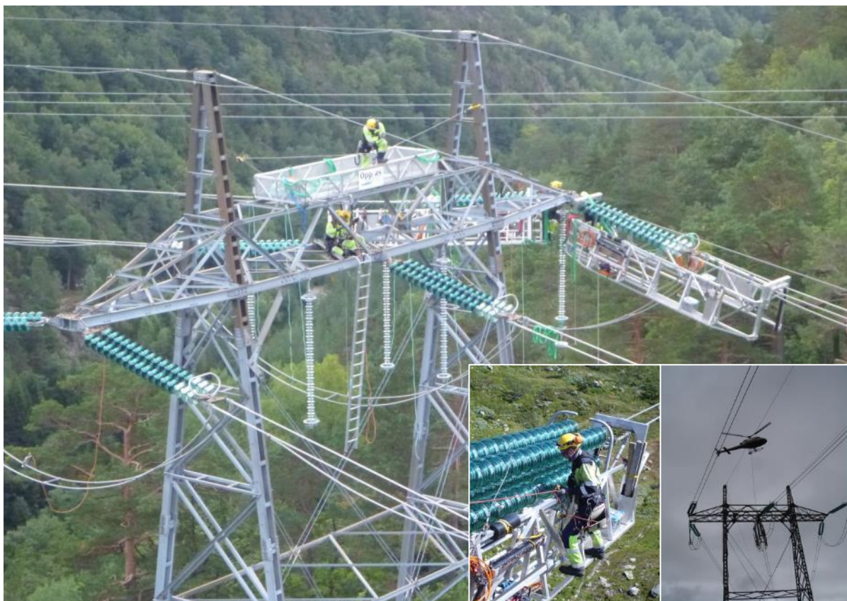
Figur 12: Bruk av jigg ved forlengelse av isolatorkjede i forankringsmast (bilder: Opp AS).
