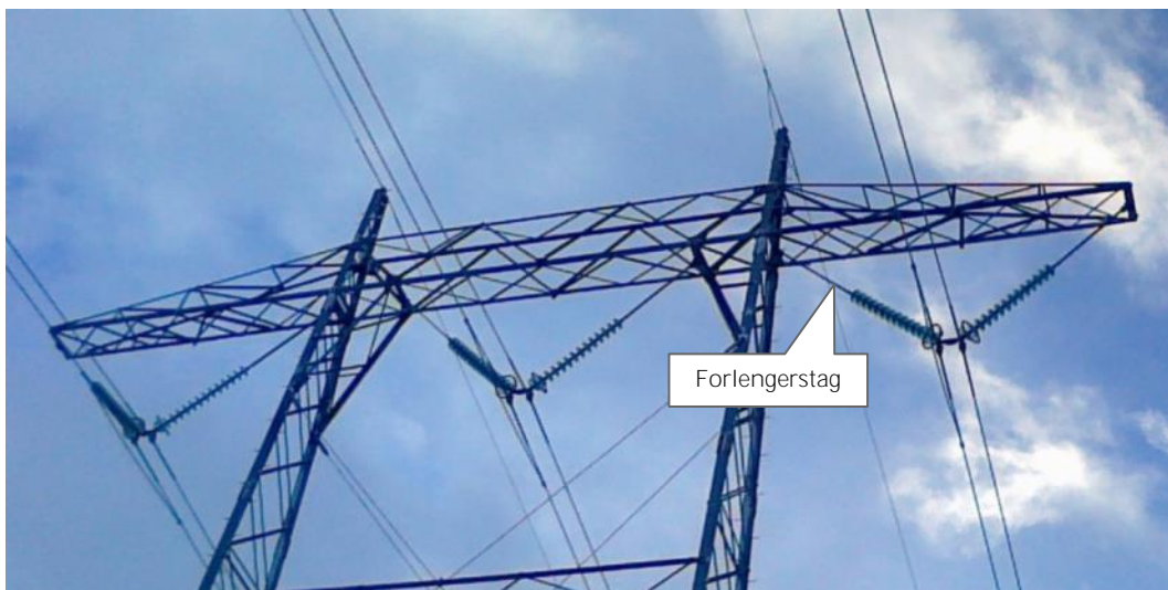
Figur 5: 300 kV bæremast med to liner per fase (dupleks) før oppgradering.
