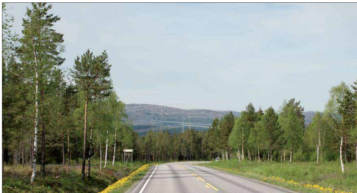
1. Namsen. 420 kV-ledningen vil gå parallelt med eksisterende 300 kV-ledning. Ved kryssing av rv 17 vil ledningen gå i samme skoggate som eksisterende og bli godt synlige fra veien.
