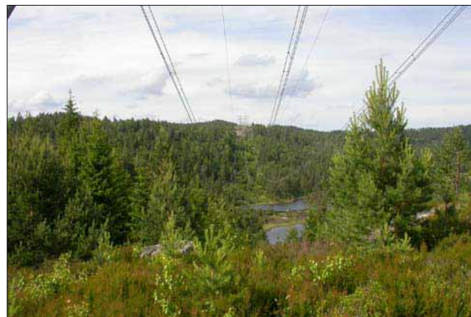
Eksempel på begrenset skogrydding. Her på ledningen mellom Kristiansand og Skåreheia (Foto: Aase Skaug)
