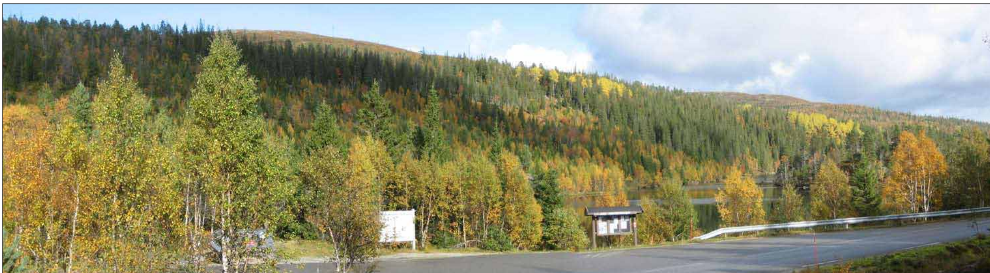
16. Øyungen og Vassdølin. Ledningen går sør for Vassdølheia parallelt med eksisterende regionalnettsledning. Her fra parkeringsplassen til Vassdølsetran. Foto: Per Reidar Hagen
