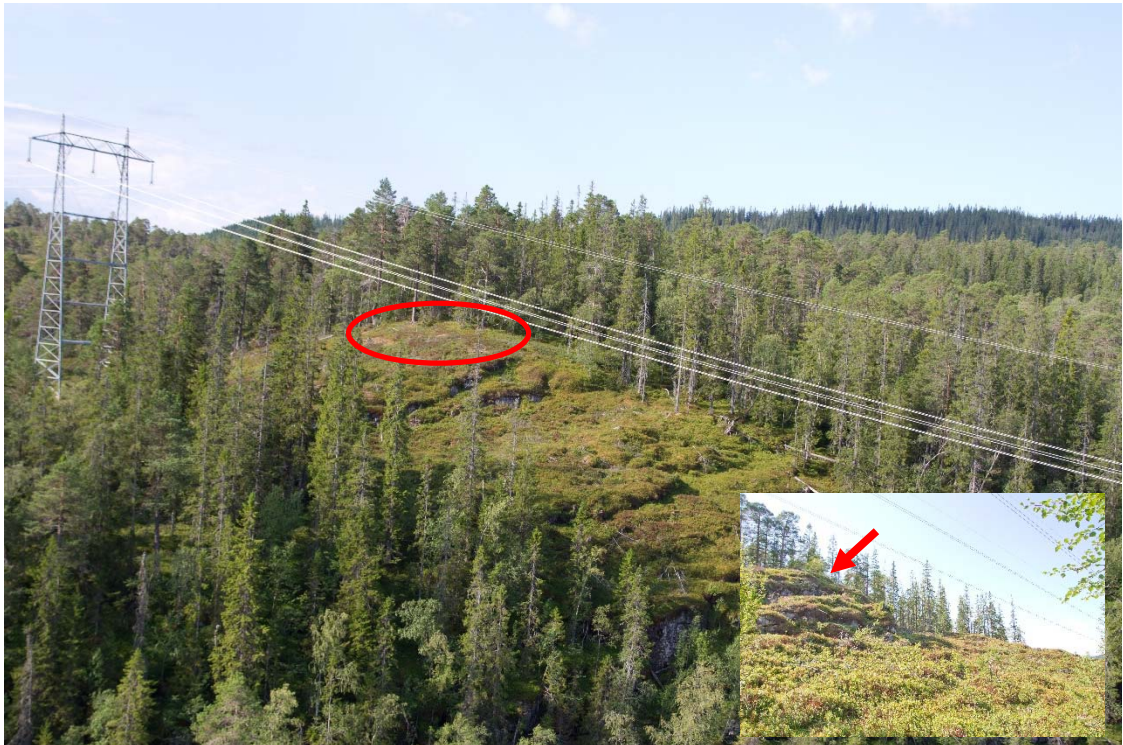
Figur 2 Området der terrenget må senkes. Innfelt bilde viser fjellnubben der avstanden mellom lina og bakken er for kort.
