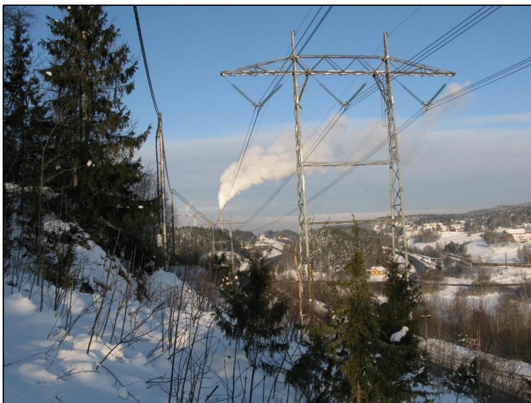
Figur 19. Skjerming med strømsløyfe ved Nyjordet i Oslo. Strømsløyfen (til venstre i bildet) er montert mellom kraftledningen og boligbebyggelsen.
