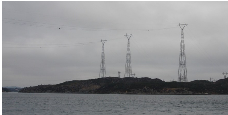
Figur 6: Mastene ved Karmsundet ruver i terrenget.
