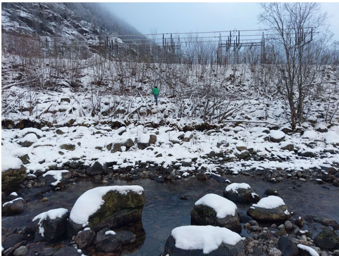
Figur 6. Oppslag av orekratt i eksisterende erosjonssikring langs Austrepollelva. Personen i bildet står midt i erosjonssikringen som skal bygges om, og hvor det er nødvendig å rydde vegetasjon.
