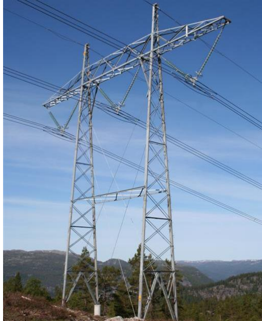
Figur 5: Ny tripleks 420 kV bæremast
