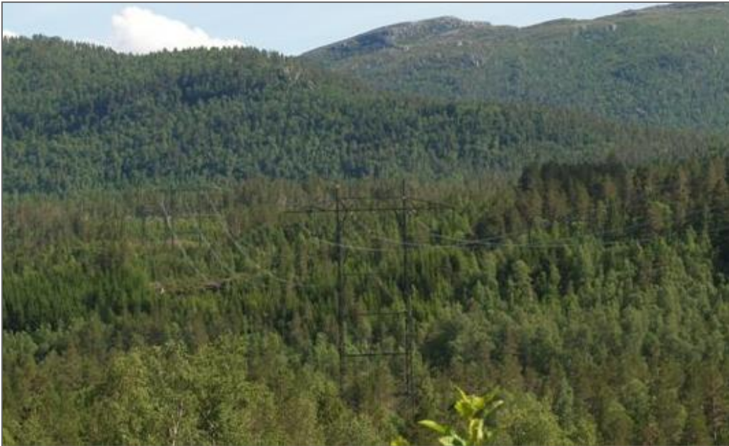
Figur 8: Bilde av kamuflert kraftledning. Her er mastene malt mørk olivengrønn for å etterligne skyggene i terrenget. Linene er mattet, og isolatorene er av kompositt i stedet for av glass som er vanligst å benytte.
