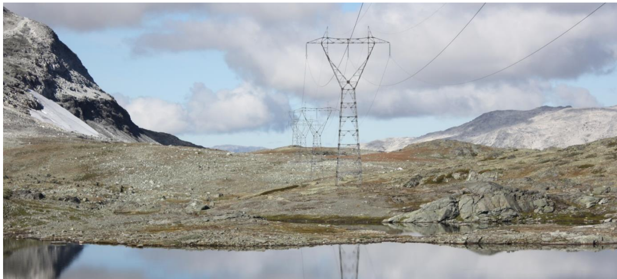
Figur 3: Dagens ledning har en gammel mastetype (Tron Horn-mast)
