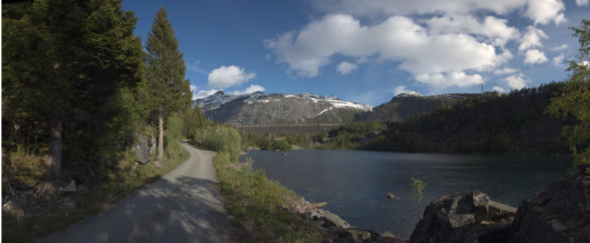
Figur 17: Ringedalsdammen i Skjeggedal, like ved Åsen transformatorstasjon. Demningen er bygd i håndmeisla granitt. Foto: Kraftmuseet, Norsk vasskraft- og industristadmuseum
