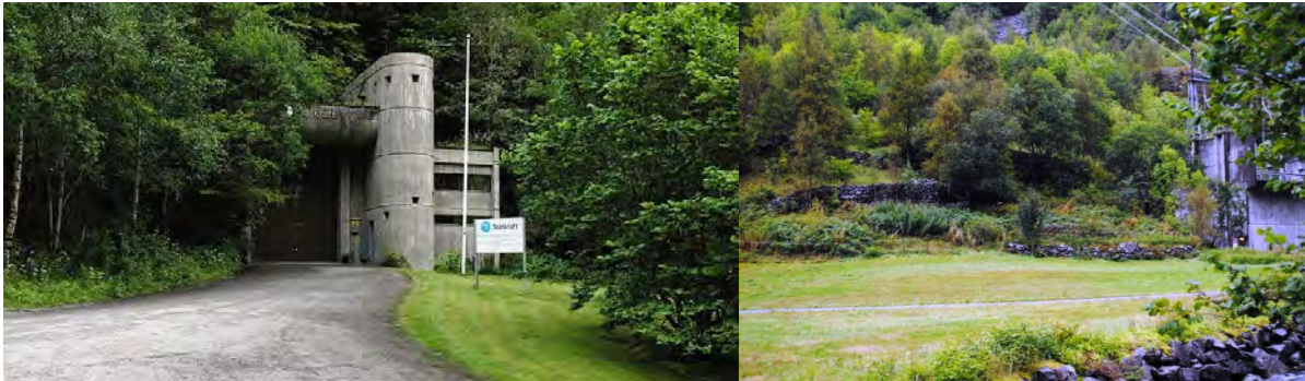
Figur 8 Hylene kraftstasjon, gammel kulturmark og trafostasjon.
