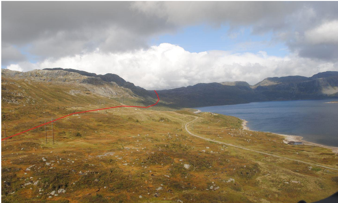
Figur 4-7. Sandsavatnet sett mot nord. På denne strekningen vil den nye ledningen bli bygget på vestsiden av eksisterende ledning Lyse-Saurdal.
