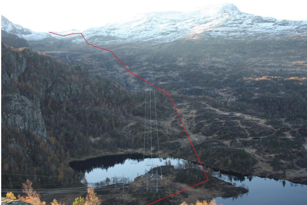
Figur 4-3. Vatnedalsvatnet i Sauda kommune. Ny 420 kV-ledning Sauda-Hylen blir liggende på vestsiden av eksisterende ledninger, som antydnet med rød strek. Ledningen til venstre rives.
